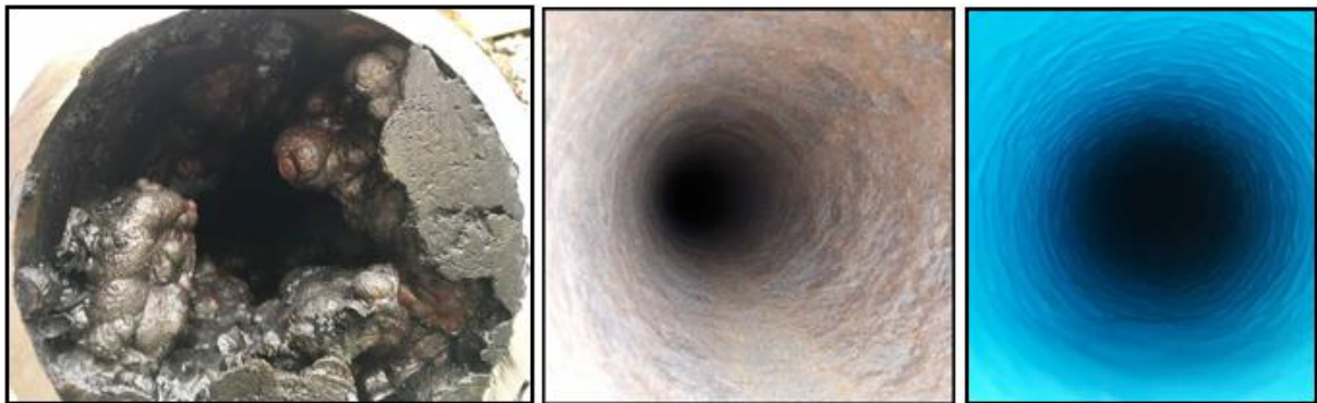
Conduite avant et après le nettoyage, et après la pose de la résine Tomahawk BluKote™.
